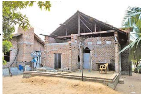
UN Habitat funded house
